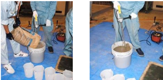
ハンドミキサーによるグラウト材混練
