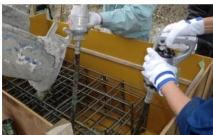
写真-1 コンクリートの打設状況
