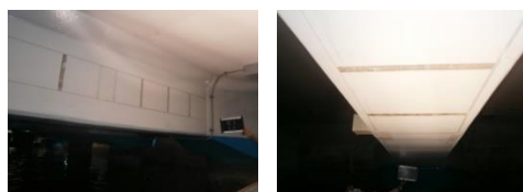
貼付け型シート陽極（施工箇所 No. 1, No. 3）
