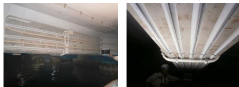
貼付け型モール陽極（施工箇所 No. 2）
