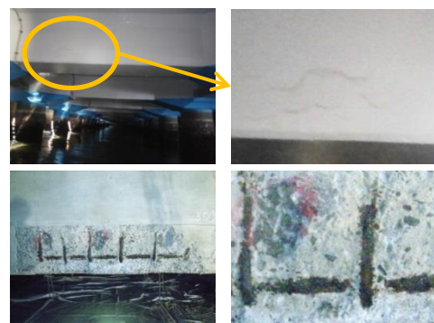
写真-1 施工箇所 No. 2 の側面-1 の状況
