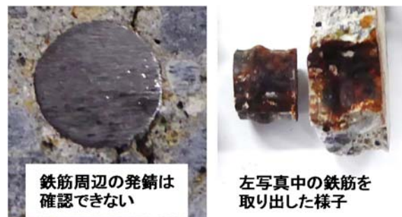
図-5 切断時に鉄筋周辺の発錆が確認できない例
