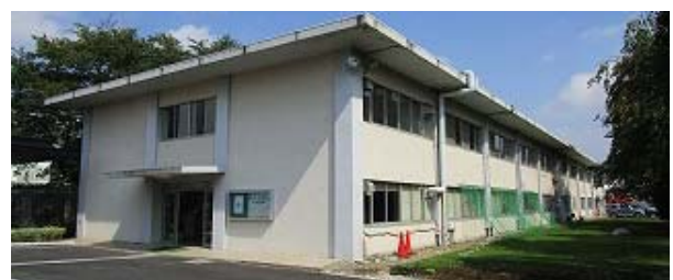
写真-1 調査した RC 造建築物の外観
