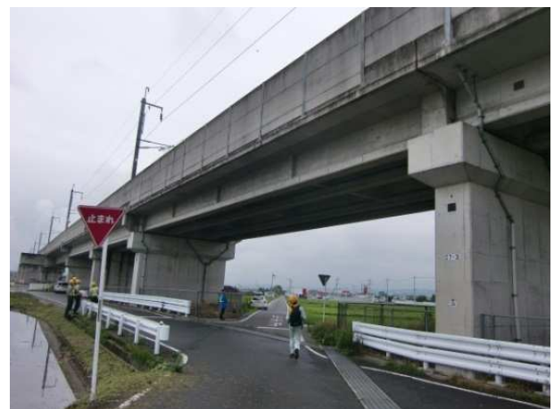
写真-2 B 橋りょう全景
