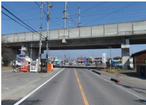
写真-1 A 橋りょう全景
