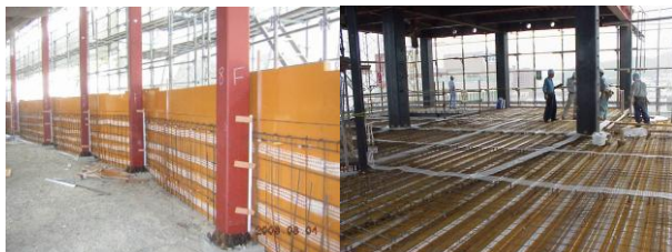
※白い帯状のものが HN で、鉄筋に設置されている
