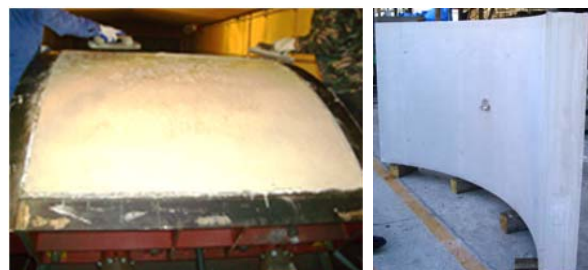
写真-1 低炭素型配合の表面仕上げ状況 と脱型後の外観
