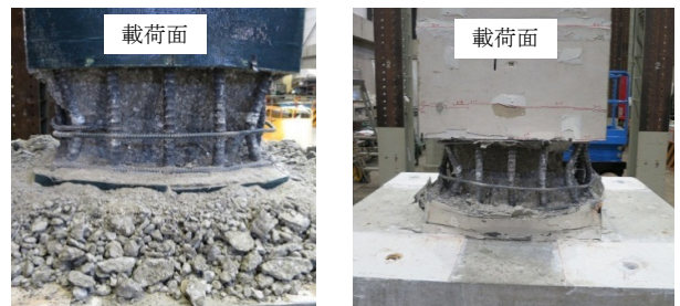
写真-5 はつり後の基部の損傷状況
