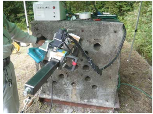
写真-4 穿孔機を用いた長尺部材の穿孔実験
