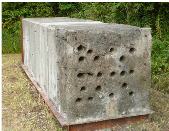
写真-2 長尺部材の穿孔断面
