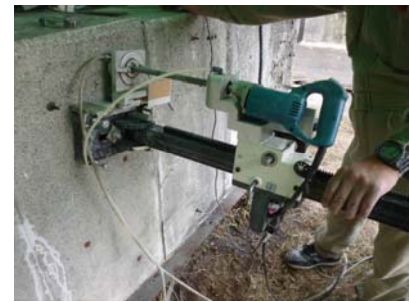
写真-3 穿孔機を用いた長尺部材の穿孔実験
