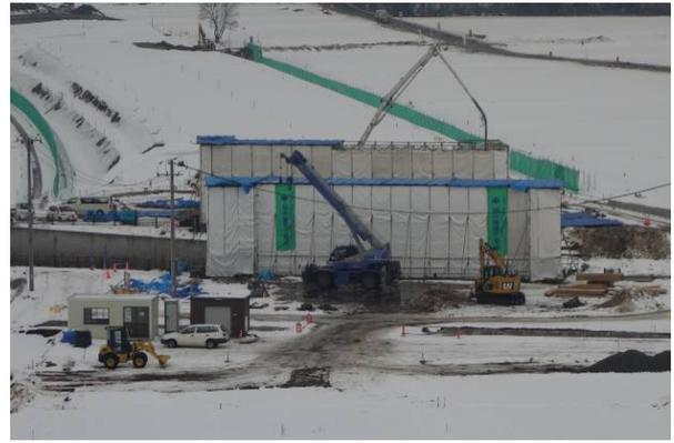
写真-1 寒中コンクリートによる橋台の施工状況
