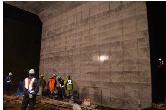
写真-3 大畑団地本線 Box の側壁
