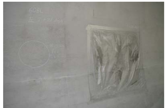
写真－2 脱型後のシート養生（八雲第一トンネル）
