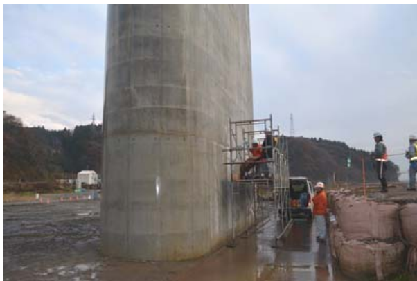
写真-5 降雨の影響を受けた新気仙大橋 P4 での計測
