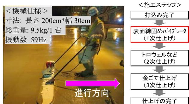
図-1 表面締固めバイブレータの仕様および施工手順
