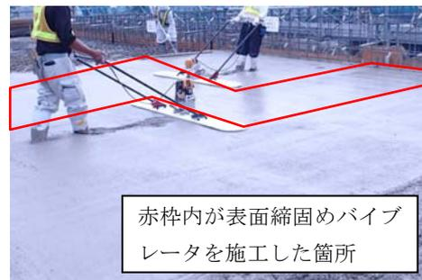
図-4 表面締固めバイブレータ施工後の様子（夏期）
