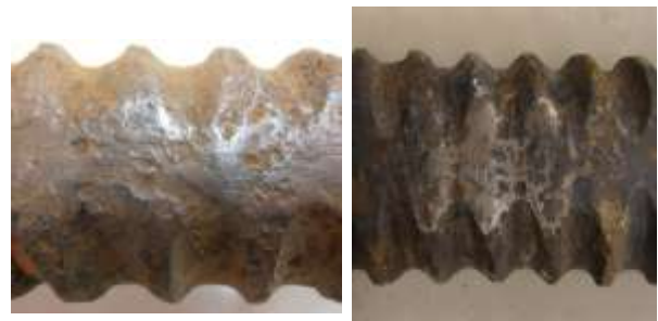
写真-3 5%腐食鉄筋(左：電食，右：塩水噴霧)
