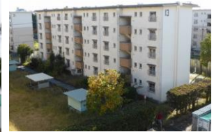
写真－2 建物外観(B)
