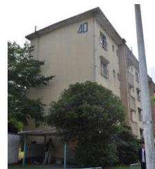
写真－3 建物外観(C)
