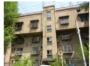
写真－4 建物外観(D)
