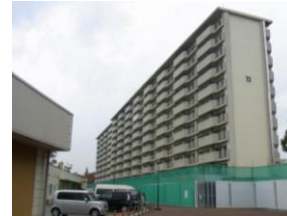
写真－1 建物外観(A)
