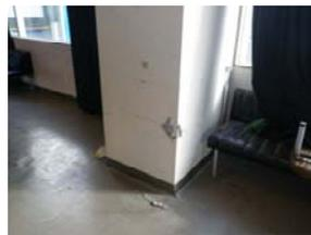
写真-11 柱の曲げひび割れ
