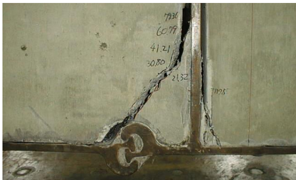
写真-2 目開き状況 (試験体 No.2)
