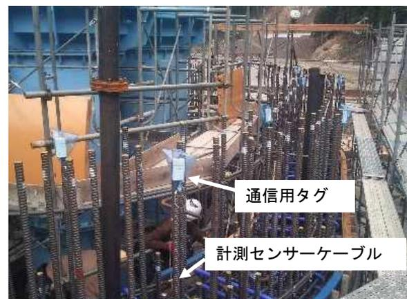
写真-2 計測機器の設置状況
