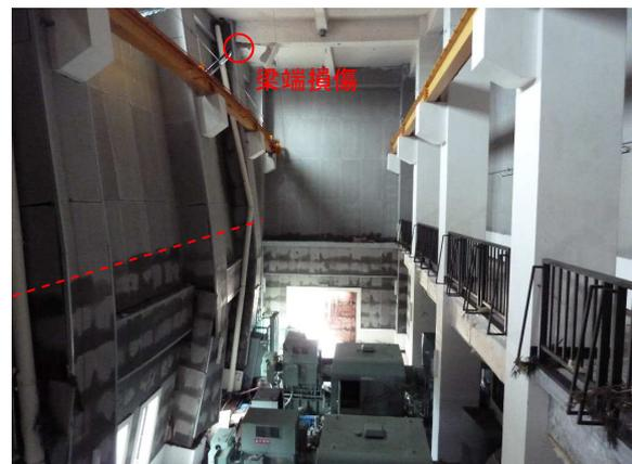
写真-2 被災建築物 A 内部（点線は痕跡最大高さ）
