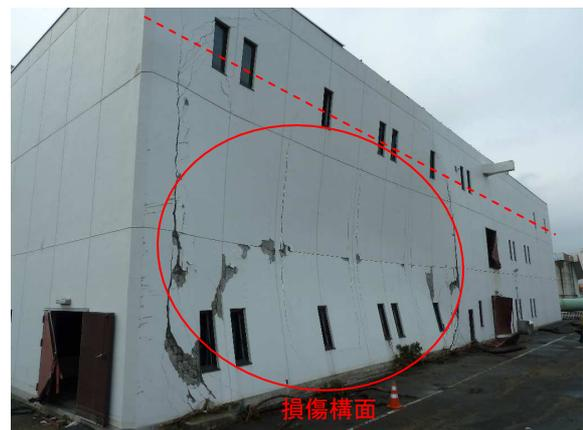
写真-1 被災建築物 A 外観（点線は痕跡最大高さ）
