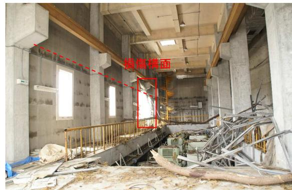
写真-4 被災建築物 B 内部 (点線は痕跡最大高さ)
