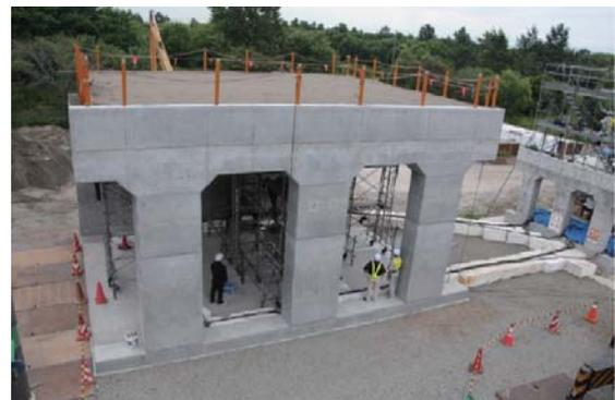
写真-1 実規模RC製ロックシェット
