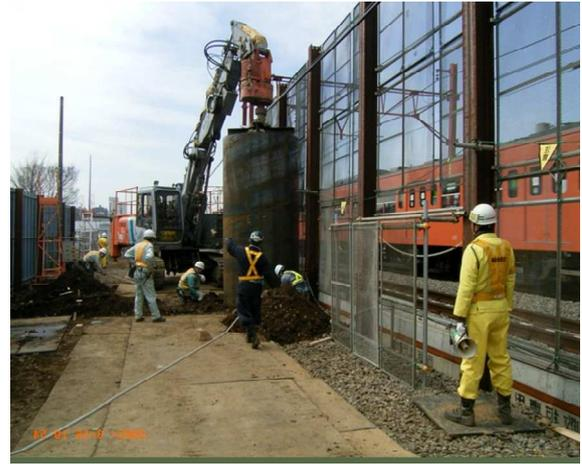
写真-2 補強鋼管を用いた工法
