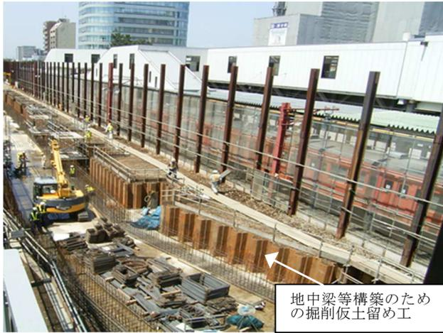
写真-1 仮土留めを用いた従来工法
