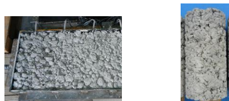
写真－２ 供試体 H25 と材料試験用供試体
