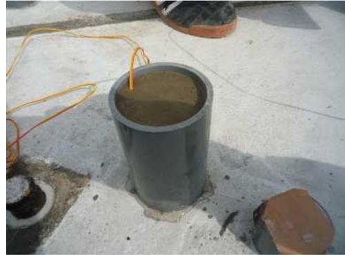
写真 - 9 超速硬無収縮モルタル充填状況(No.2-2)
