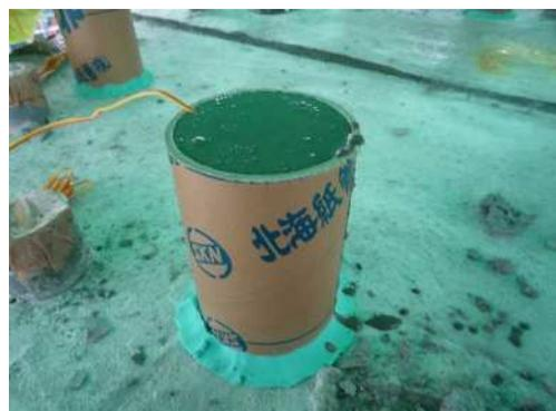
写真 - 13 超速硬無収縮モルタル充填状況 (No.3)
