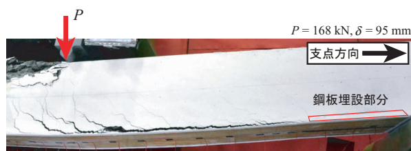
写真-4 終局時近傍におけるひび割れ性状
