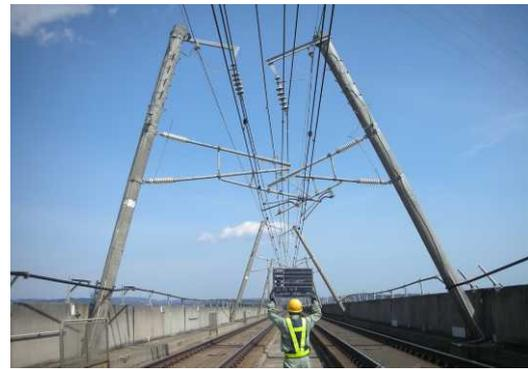
図-1 折損変位した PC 電化柱 (砂基礎)
