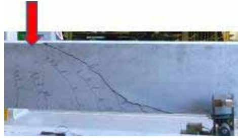
写真-3 Case-1 の破壊状況
