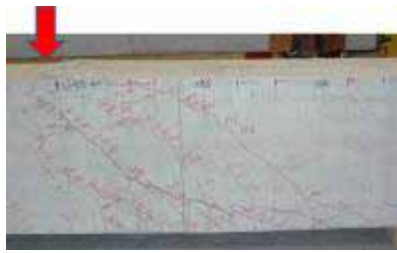
写真-5 Case-3 の破壊状況
