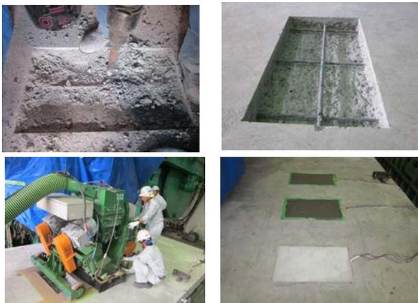
写真-1 断面修復部の施工状況
