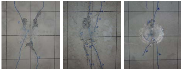
No.1 変位：7.87mm No.2 変位：6.54mm No.3 変位：10.99mm 写真-3 衝突部近傍の破壊状況（衝突回数 45 回）
