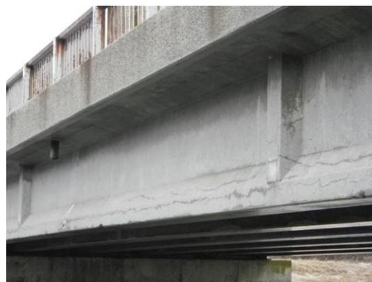
写真-2 ポストテンション式 PCT 桁の事例
