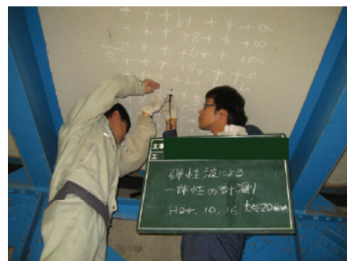
写真-2 剥離状況の測定状況 (B橋)
