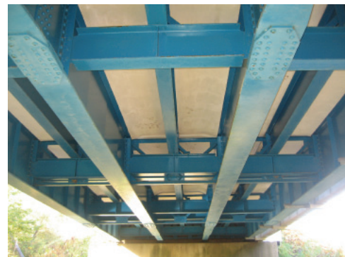
写真-1 下面増厚状況 (A橋)
