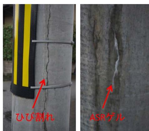
写真二 電柱のASR事例(富山県、神通川産川砂、HOPC)
