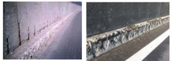
図-1 RC壁高欄の劣化事例
