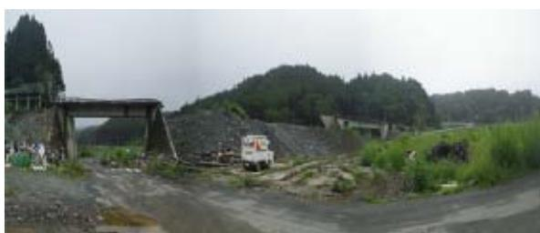
図-9 背面盛土のみ流失した鉄道橋（南三陸町）
