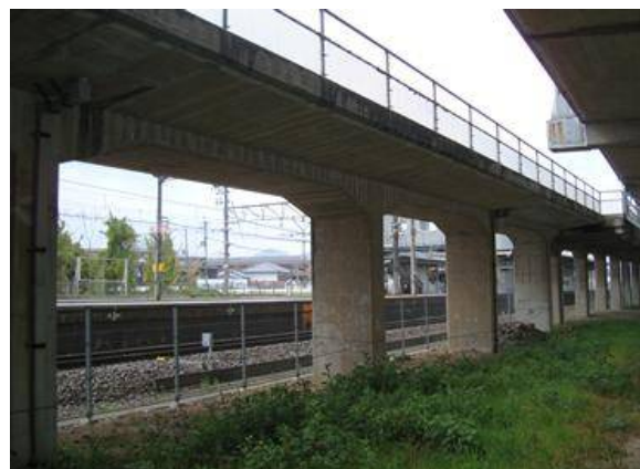
写真-1 脱塩・再アルカリ化工法適用構造物
