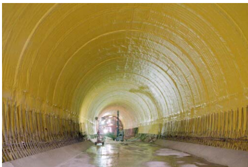
写真-2 表面平滑工法による仕上がり状態
