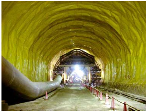
写真-1 従来工法による仕上がり状態
