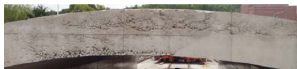
写真-2 普通 con の仕上り状況（吹上げ口側）
