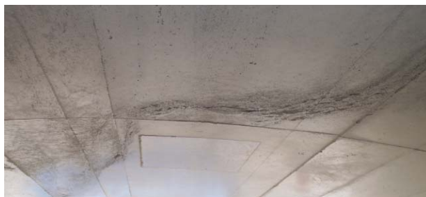
写真-3 普通 con の仕上り状況（内空側）
