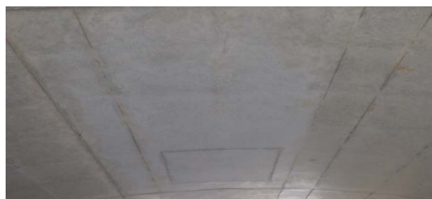
写真-5 増粘剤系中流動の仕上り状況（内空側）
