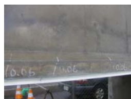
写真－3 下フランジ部ひび割れ上側ひび割れ
