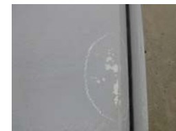
写真－4 塗装面のひび割れ及び剥れ
