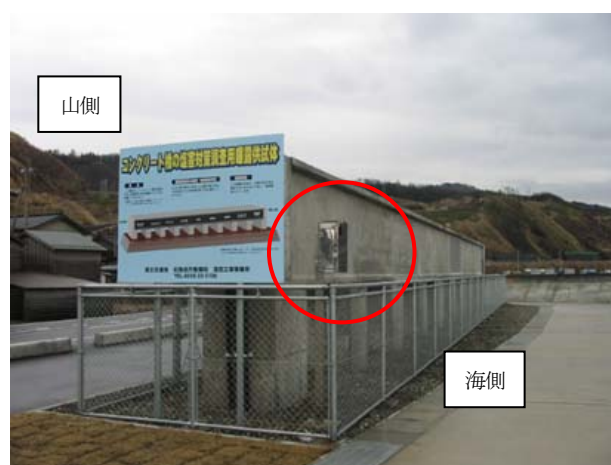
写真-2 飛来塩分捕集器の設置状況
