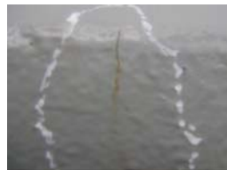
写真－4 塗装面のひび割れ及び剥れ
