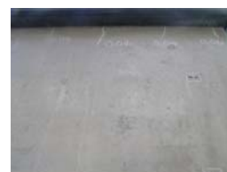
写真－3 下フランジ部ひび割れ上側ひび割れ
