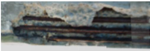
図-6 鉄筋腐食劣化の画像例
