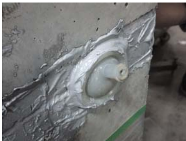
写真-3 セメント系補修材の注入
