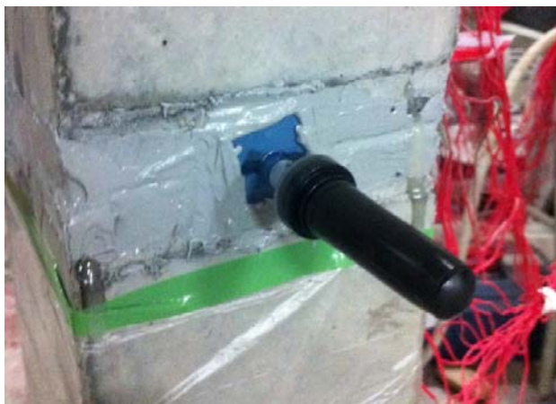
写真-2 エポキシ樹脂の注入
