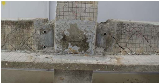
(b)No.2(モルタルと鋼板により合成補強)
