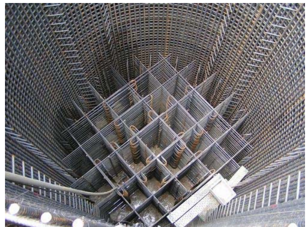
写真－1 中間帯鉄筋が多数配置された大口径深礎の例 （(株) 都建設 HP より転載）
