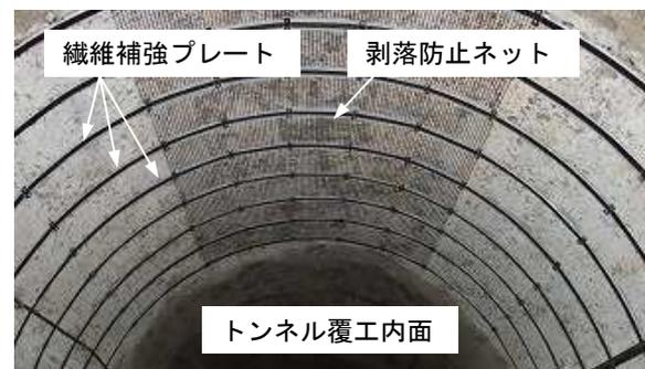
図-1 バサルト繊維補強プレート帯板接着工法の概要
