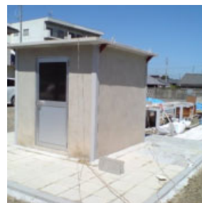
写真-1 実証実験風景 図-2 建屋寸法 (mm) (活性アルミナ粉末モルタル)
