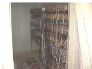
b. 試験体設置状況
