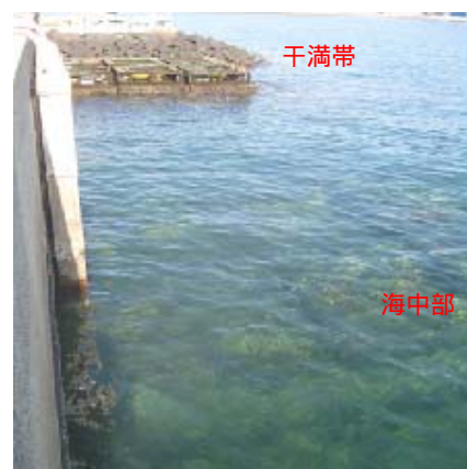
写真 - 1 暴露場写真
