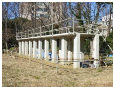
図-1 中規模柱試験体(写真右手前が東)
