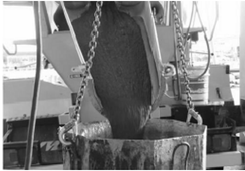
写真－７ 運搬後の排出状況（100km 運搬後）
