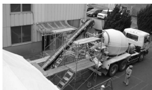
写真－４ ベルトコンベヤを用いた繊維投入例
