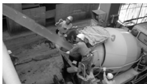
写真－５ シュートを用いた繊維投入例
