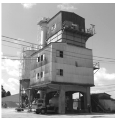
写真－３ ミキサ B を有するプラントの外観
