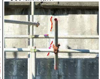
図-8 変状抽出結果の一例
