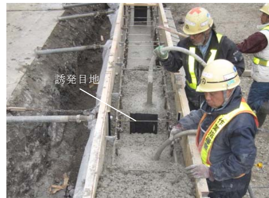
写真-4 打設状況
