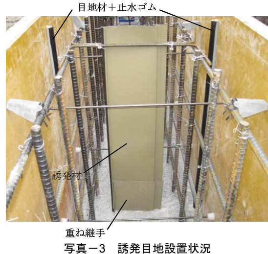
写真-3 誘発目地設置状況
