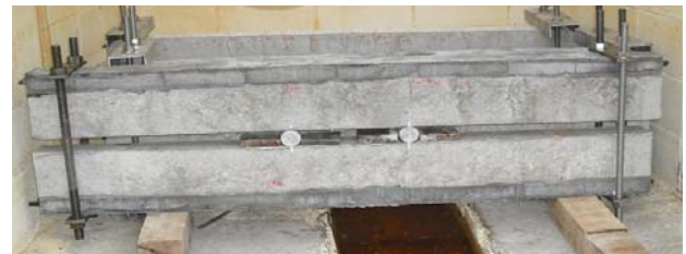
図-6 塩水散布供試体
